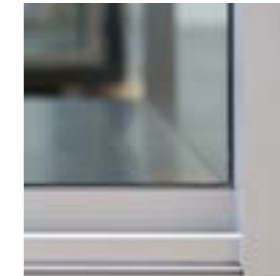
Détail extérieur du châssis : dormant-traverse basse
