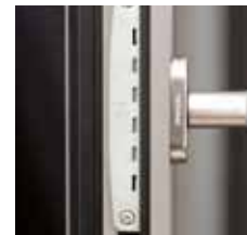
Manœuvre des fermetures par boîtier crémone bidirectionnel
