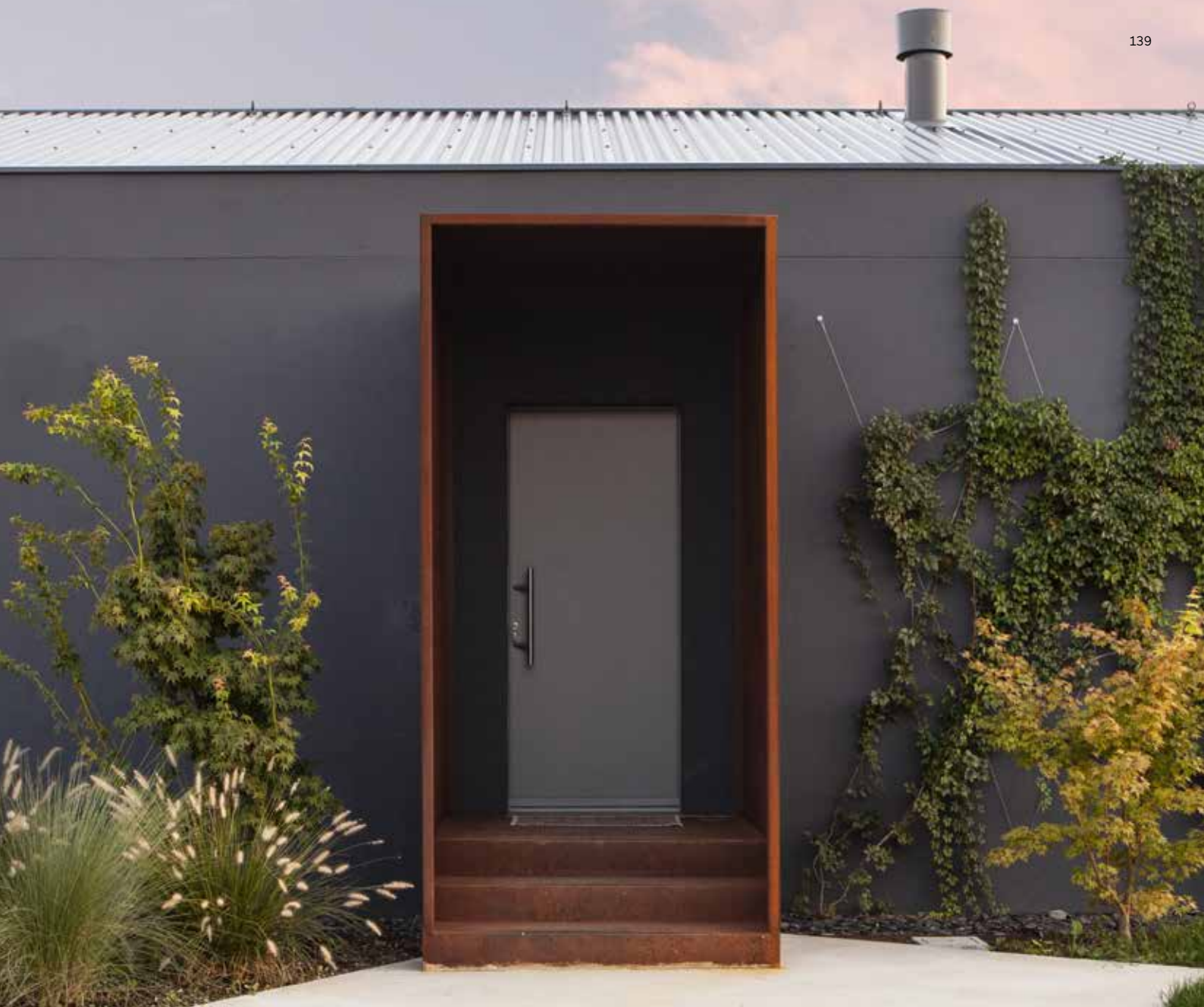
↑ La maison passive Shell PassiveHouse : avec son esthétique sobre et lisse, la porte d'entrée Finstral procure une entrée confortable à cette maison basse consommation à Cesena.
